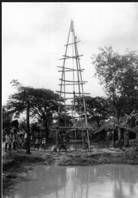
Forage de puits tubés.
