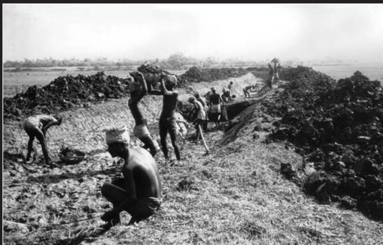
Creusement d'un canal d'irrigation, Jhikhira.
