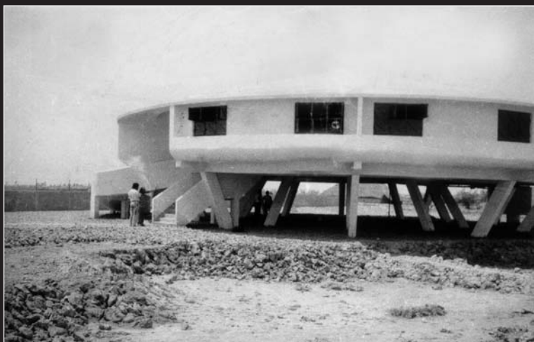
L'abri anticyclone enfin terminé à Jhorkhali.
